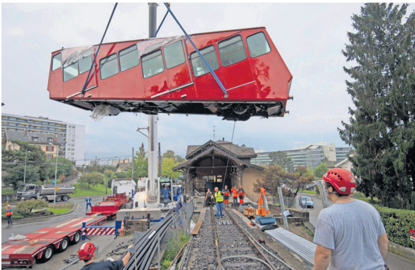
Rénovés, les deux véhicules du funiculaire du Mont-Pèlerin ont été déposés sur leurs rails, hier, à Vevey. PATRICK MARTIN
