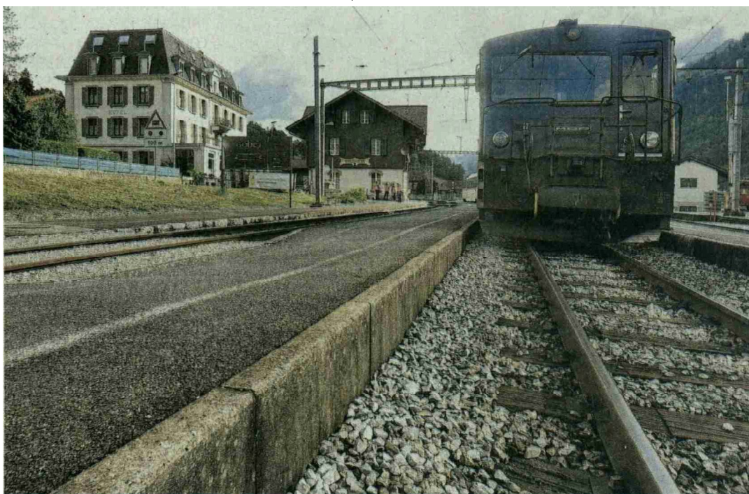
Für die «GoldenPass Line»-Züge werden die Perrons des Bahnhofs Montbovon verlängert. Bild Vincent Murith
