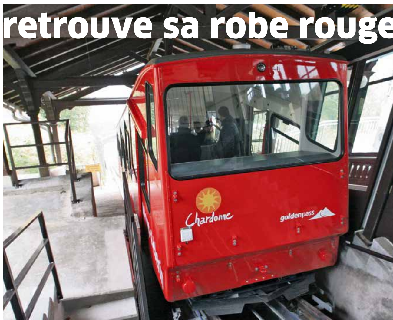
La nouvelle machinerie permettra à la voiture de s'arrêter aux stations au centimètre près pour permettre un accès aisé aux personnes à mobilité réduite. SG
